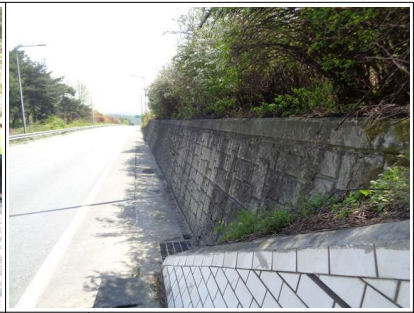
15 진출부 옹벽 전경
