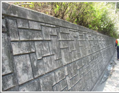
14 진출부 옹벽 전경
